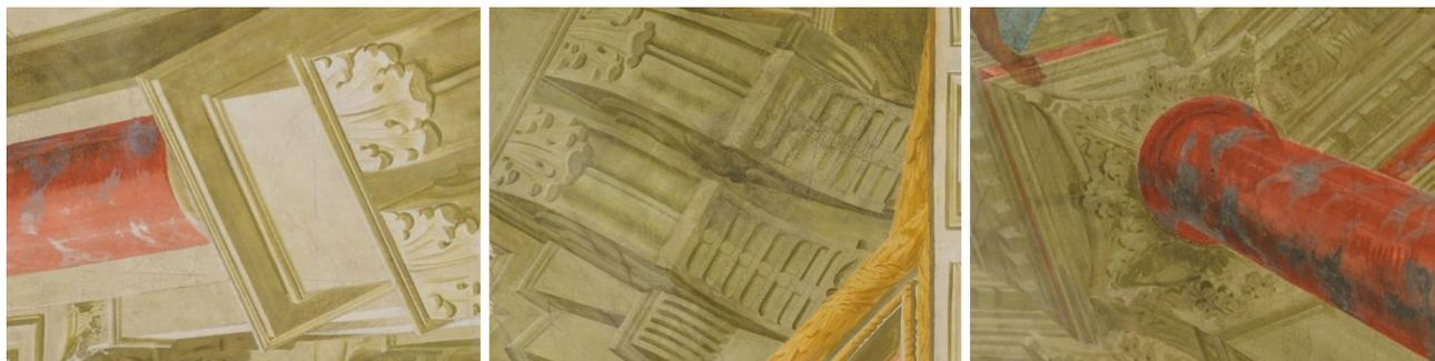
Fig. 43. Segni di costruzione ancora leggibili sulla volta: a sinistra, la *graticola*; al centro, disegno a carboncino; a destra, incisioni dirette per il tracciamento di circonferenze.
