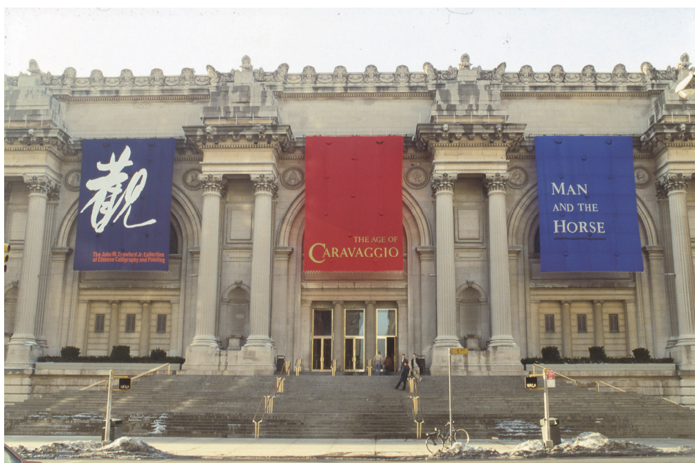
Fig. 77. Ingresso principale del Metropolitan Museum of Art di New York nei mesi di apertura della mostra The Age of Caravaggio
