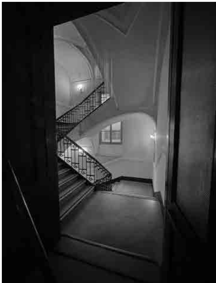
54 Stato attuale della scala (fotografia di Edoardo Piccoli, 2022).
